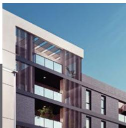
Perfilería de aluminio con rotura de puente térmico y doble acristalamiento
